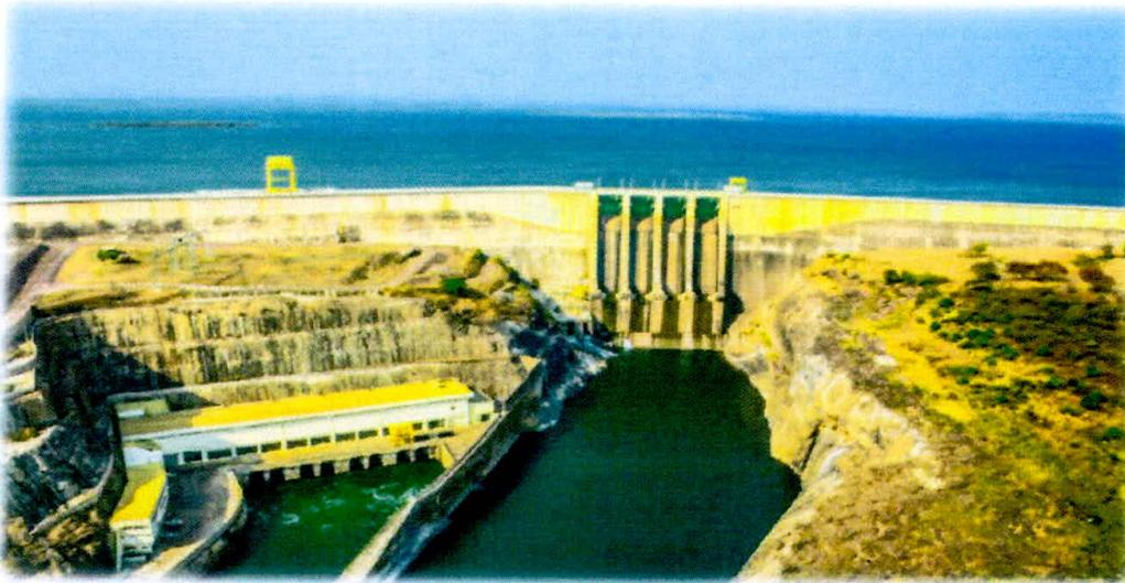
Figura 2.17: Panorâmica do descarregador de fundo do Aproveitamento Hidroeléctrico de Capanda
